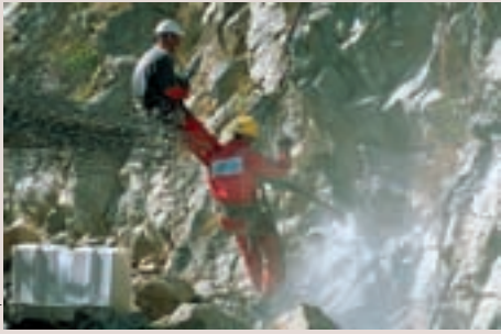
Mise en place de tirants pour ancrer le rocher du talus d'une route de montagne récemment élargie.
